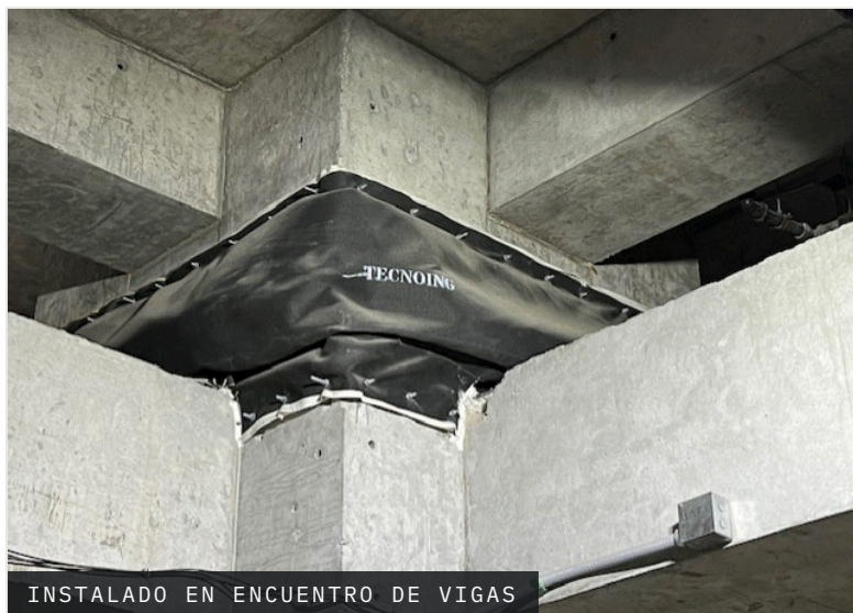
AISLADOR SÍSMICO PROTEGIDO
